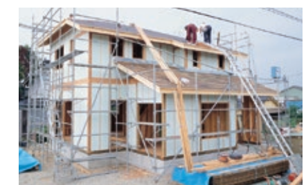
屋根材・サッシ枠施工
