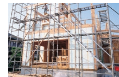
2階壁パネル施工
