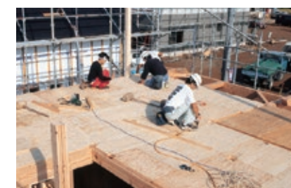
2階床パネル施工
