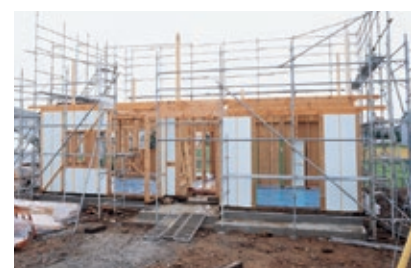
1階壁パネル施工
