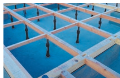
1階床組(土台)施工
